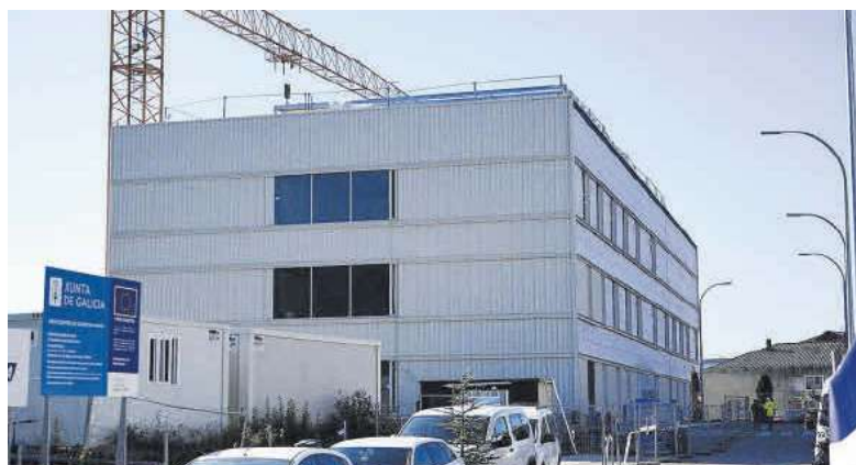
Una de las fachadas ya muestra la cubierta de aluminio definitiva. | Gonzalo Núñez
