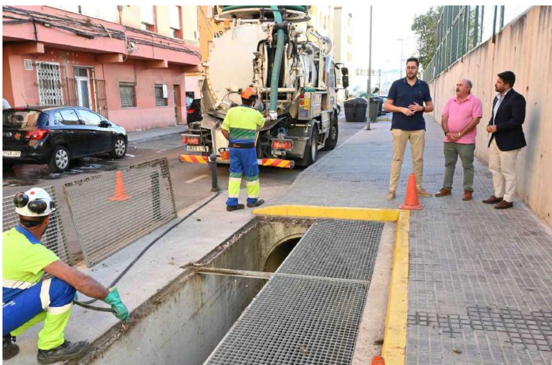
Mantenimiento red de recogida de pluviales en la calle Jacinto Benavente
