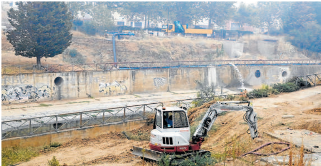
Operarios trabajando en la estación de bombeo de San Roque. ÁNGEL MÁRQUEZ
