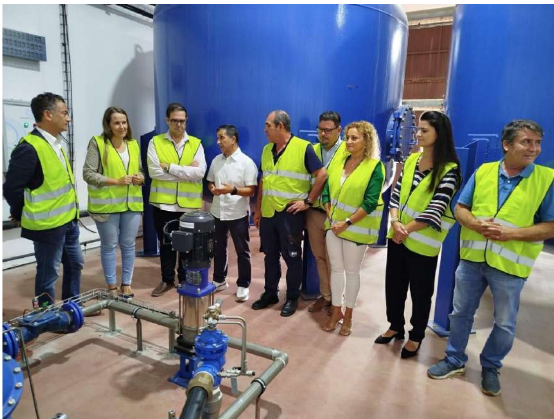
Visita al fin obras de la ETAP de Castell de Ferro
